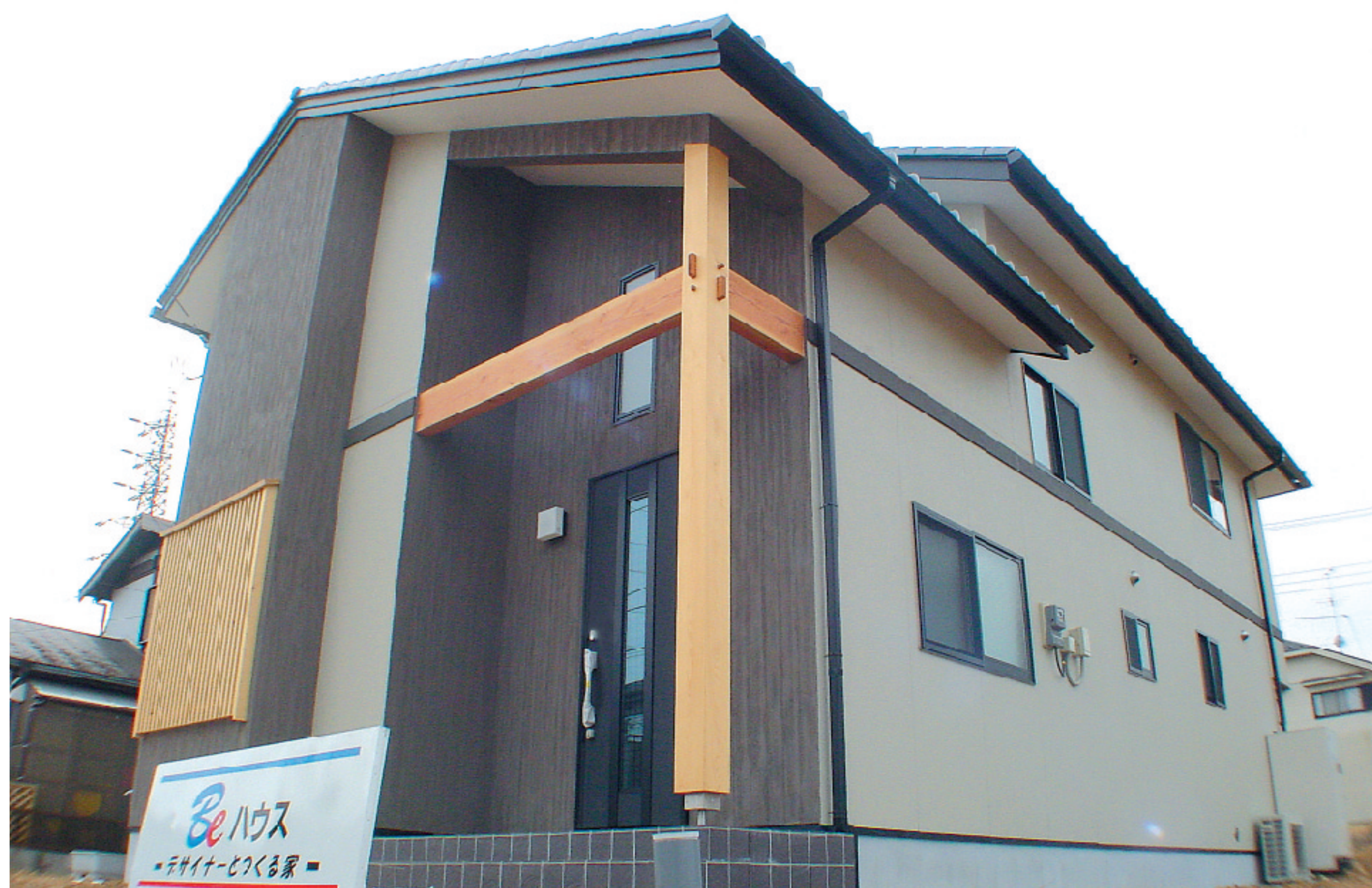
外壁は厚さ12ミリのサイディング。玄関まわりは茶色のジョリパット塗装に、木の素材を生かした飾り柱や梁が存在感を高めています
