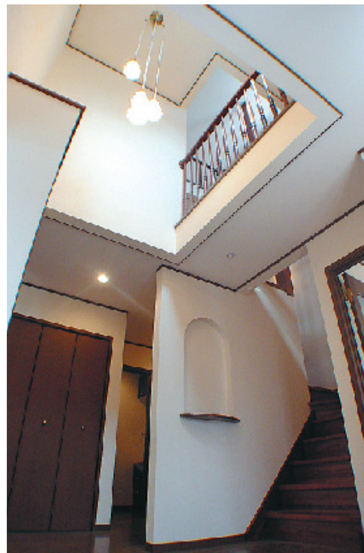
(左)コの字型とし字型を併用した階段。擁壁や蹴上げを入れないのは、デザイン的美しさと通気性に配慮したため (右)3階まで続く高い吹き抜け。日中はトップライトからの光がリビングに届きます
