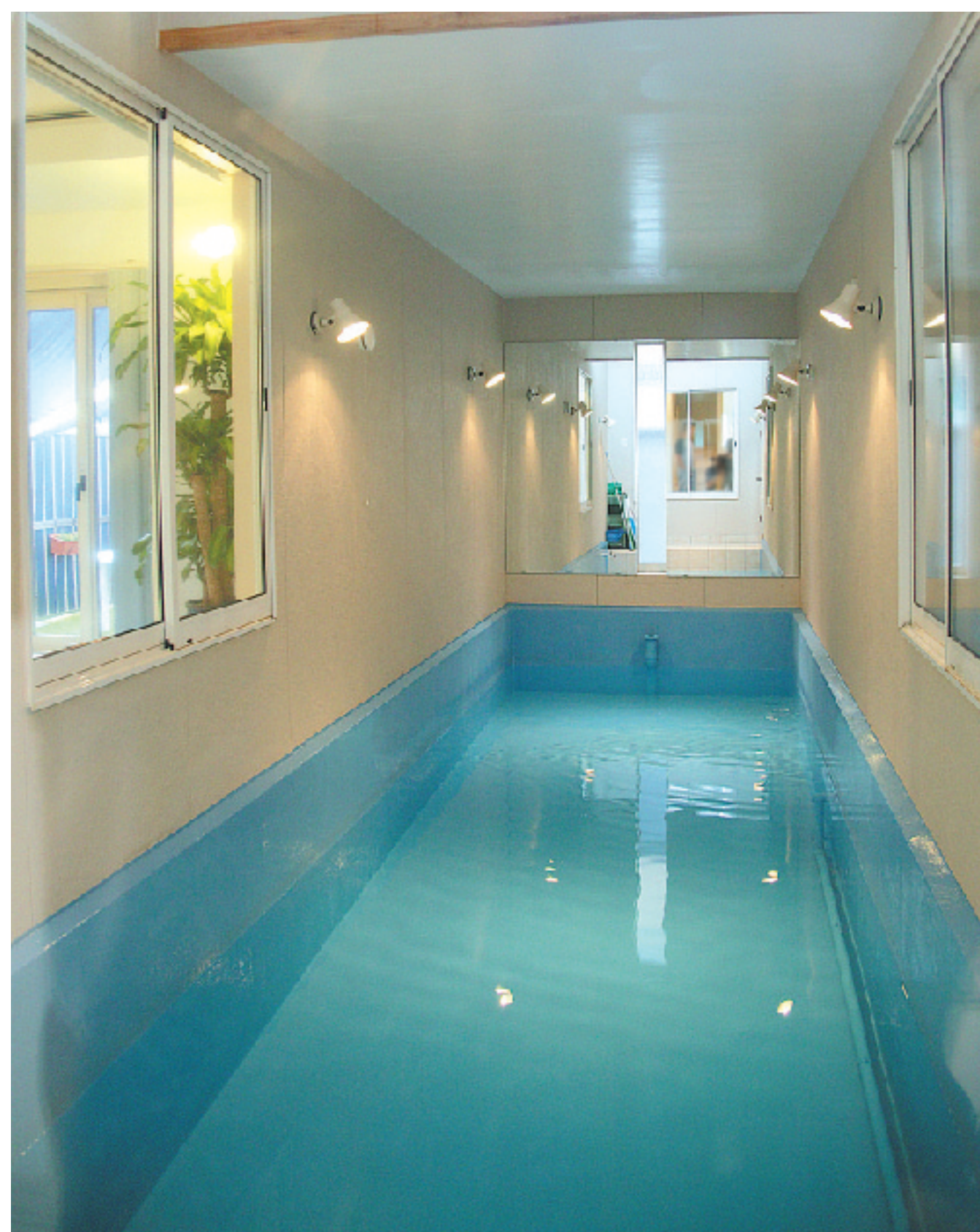
(左)コの字型の家にプールをはめ込んだ構造。プールは外壁の外にあるため、家が湿気で傷む心配はありません (右上)プールの屋根は広いルーフバルコニーになっています (右下)サウナも造作。輸入ストーンを含め40万円で完成しました
