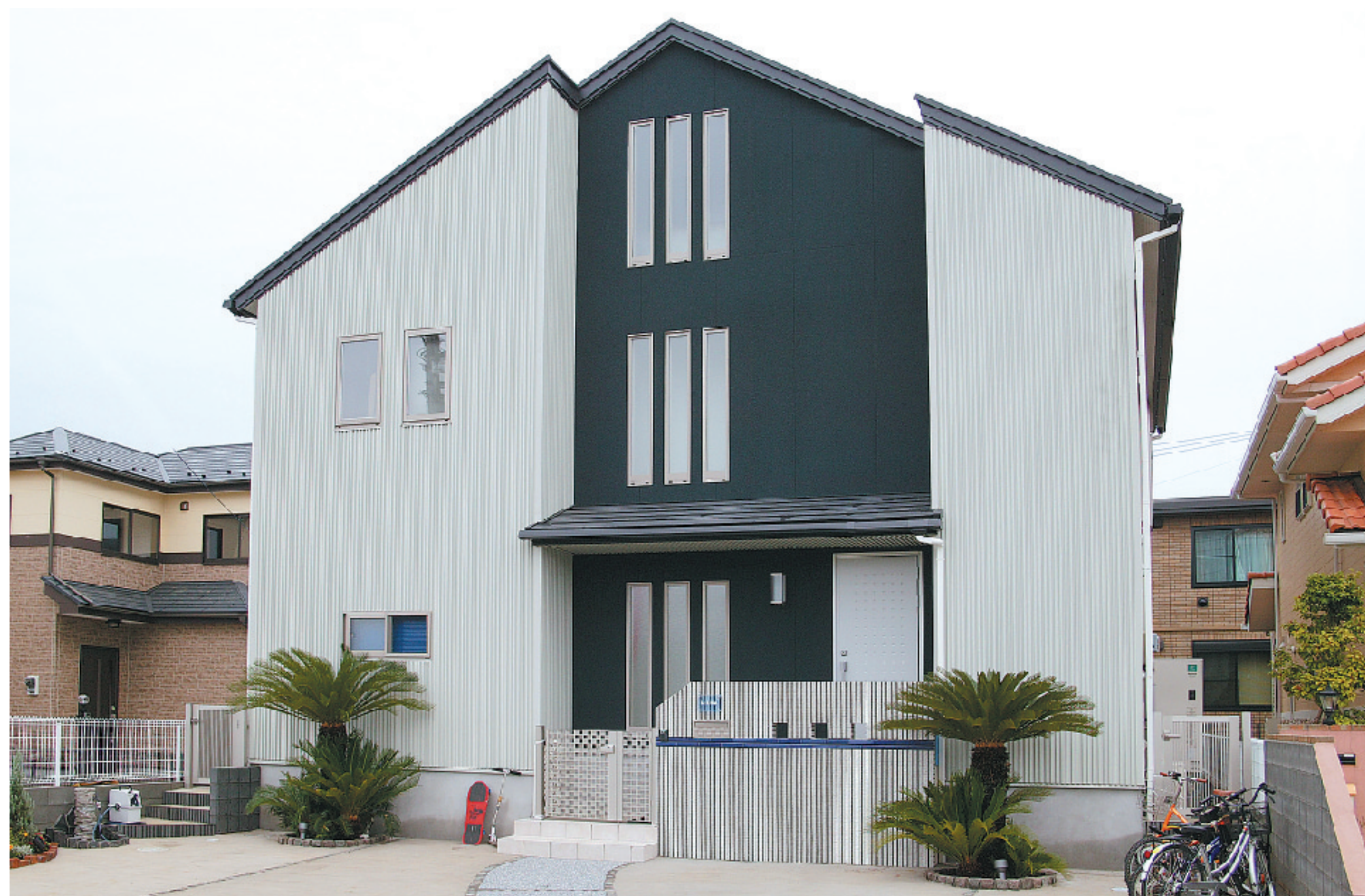
大きな家でも間延びして見えないよう、シルバーのガルバリウムと濃紺のソフトスタックでツートーンに仕上げました。夜には玄関前のソテツがライトアップされます
