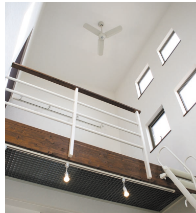
ロフトの床の一部をグレーチングにすることでより多くの光が射し込むようになっている。
