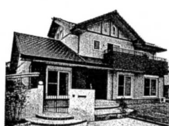
外壁にデザイン性や耐久・耐火性に優れたALCを使い、美観や安心が長く続くことにも配慮
